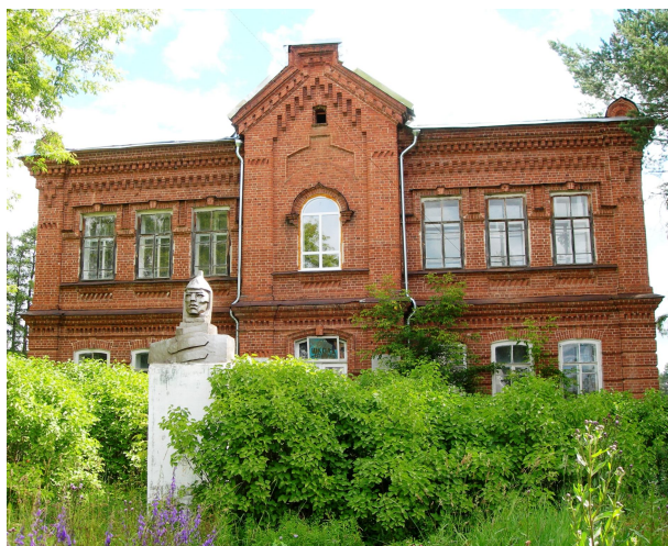
Рис. 1. Здание, где в 1919 г. располагался Закамский штаб охраны и связи. Фото С. Королёвой, 2014 г.
